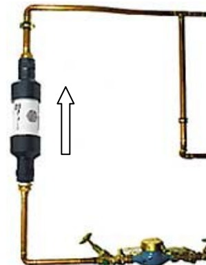
Installation du Dynamiseur à vortex: si possible verticale, le sens d'écoulement de bas en haut
